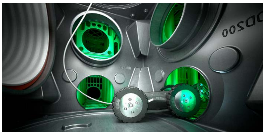
Inspekcja zbiornika poprzez studzienkę kontrolną 600 mm
