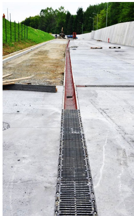
Składowisko Odpadów Komunalnych Barycz AS-300 - ponad 700mb
