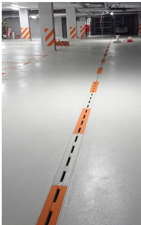
Garáže podziemne AS-A-S100
