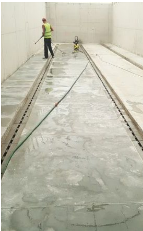
Zakład unieszkodliwiania odpadów Katowice AS-S100 N-0 - 4020 mb
