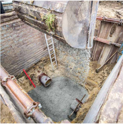
Przygotowanie podłoża
