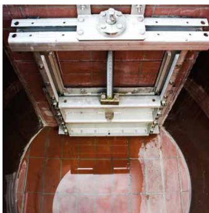
Montaż zasuwki płytowej
