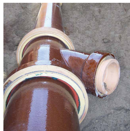
Przykład zabudowy: KERA.Base trójnik 45°
