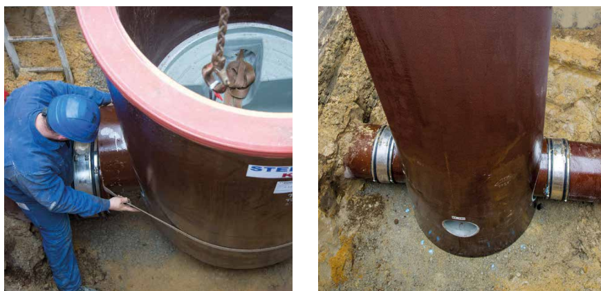
Osadzenie studni
