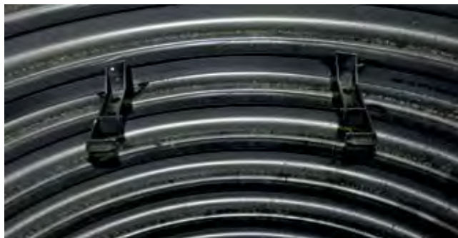
Rys. 5. Premontaż obejmy drabinki w rurze trzonowej.
