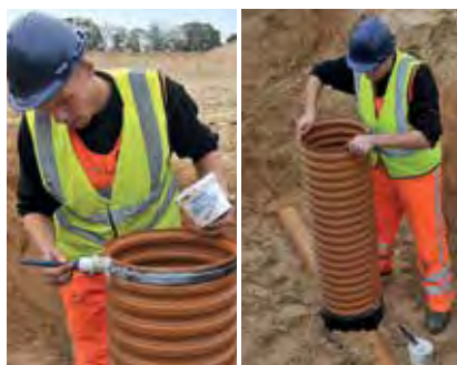
10. Trzeba nasmarować uszczelkę na rurze trzonowej i wcisnąć rurę trzonową w kielich kinety.
