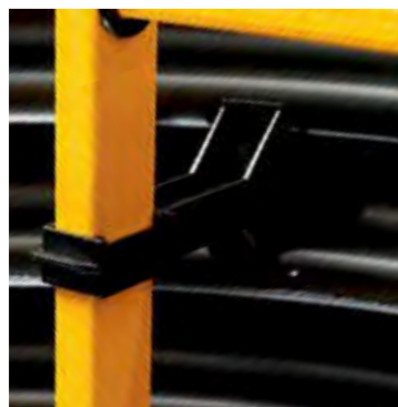
Rys. 6. Zamontowanie zaślepek przy wspornikach
