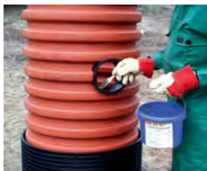
2. Następnie oczyszcza się krawędzie otworu z zadziorów.
