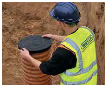
11. Zabezpieczyć studzienkę przed dostaniem się piasku podczas zasypywania wykopu.
